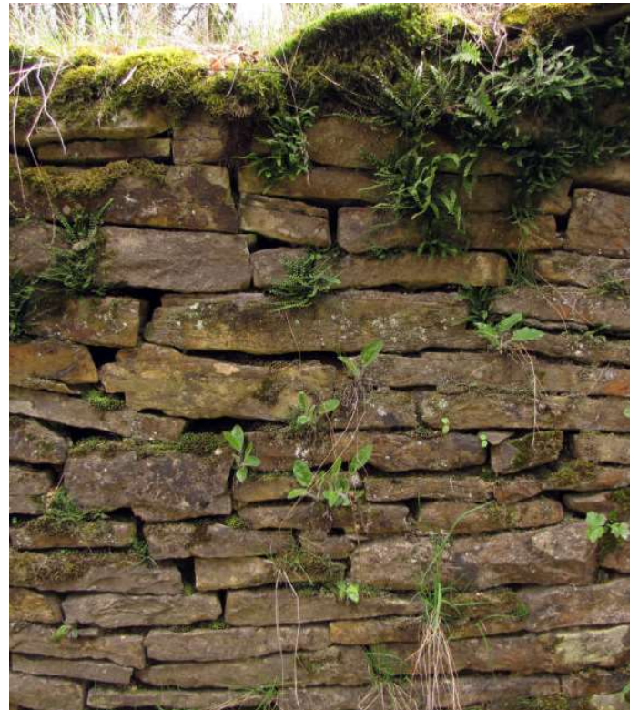
Abb. 44: Trockenmauer im Saupark (Region Hannover)
