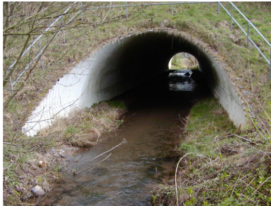
Abb. 9: Beispiel für ein Durchlassbauwerk mit durchwanderbaren Ufern (Foto: UIH/Peters)
