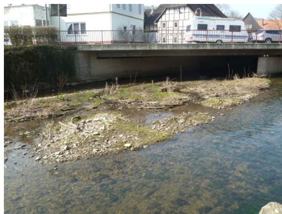
Abb. 10: Abgelagertes Geschiebematerial oberhalb eines Brückenbauwerks in der Ortslage Scharfoldendorf (Foto: UIH/Schackers)
