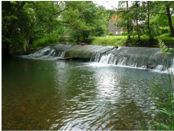
Abb. 18: Das Lennewehr bei Linse vor dem Abriss (Foto: UIH)
