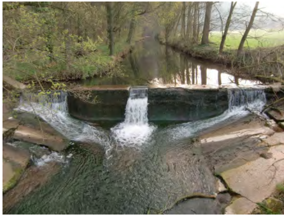
Abb. 16: Das Lennewehr bei Buchhagen vor dem Abriss (Foto: UIH)
