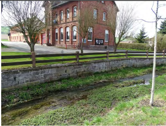
Abb. 77: Mauern und Zäune grenzen das Gewässer als Erlebnisraum aus (Foto: UIH/Christ)
