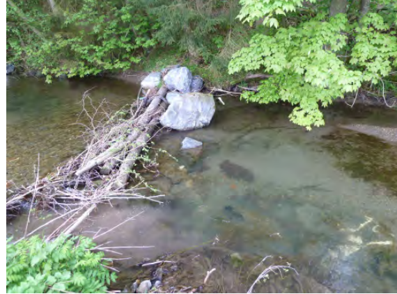
Abb. 49: Durch Blöcke im Uferbereich gesichertes Totholz (Foto: UIH/Peters)
