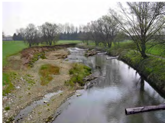
Abb. 51: Totholz als Strömungslenker zur Initiierung einer eigendynamischen Entwicklung (Fotomontage: UIH)
