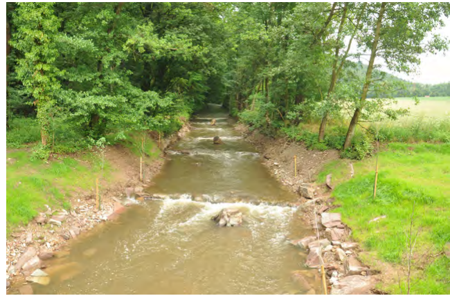
Abb. 17: Eine Raue Gleite in Steinriegelbauweise fängt den ehemaligen Sohl sprung ab (Foto: UIH)
