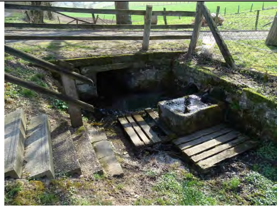
Abb. 44: verrohrter Abschnitt im Quellbereich der Lenne (Foto: UIH)
